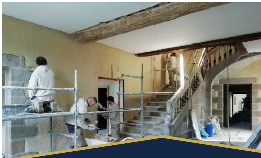
Pose de l'enduit chaux-chanvre dans le hall
